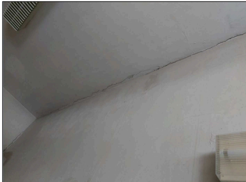
FOTO LESIONE 8 - solaio Ripostiglio
